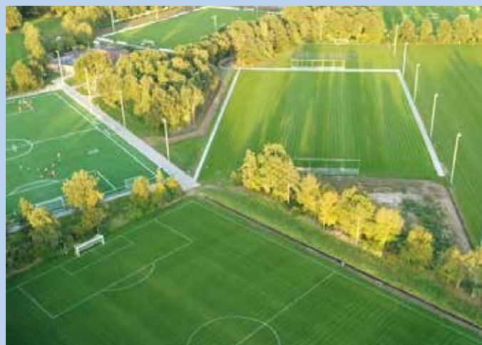
1. Sportpark, Poperinge. 2. Sportpark, Noordwest Beilen.
