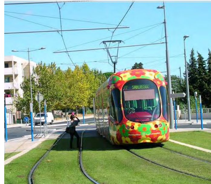
Le tram de Montpellier présente de nombreuses portions de voies engazonnées ( http://www.biodiversite-positive.fr © JL Zimmermann)
