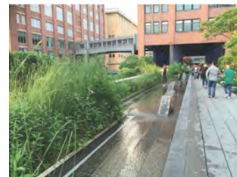
Passage en béton préfabriqué drainant avec brumisateurs (CIM Béton)
