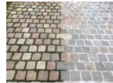
Joints différents pour usage différent : enherbés à gauche et au mortier à droite © CAUE de Paris
