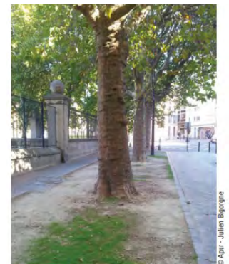
Bande perméable compactée par les piétons : l'infiltration de l'eau n'est plus assurée.
