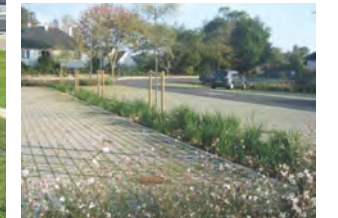
Pavés à joints larges engazonnés avec noue paysagère (CIM Béton)
