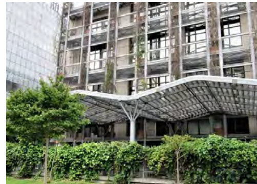
Cet exemple est très efficace dans le sens où il combine l'auvent, d'une part, qui protège le mur et le trottoir de l'ensoleillement ainsi que les usagers en journée ; et la végétation, d'autre part, qui complète l'effet rafraîchissant grâce à l'évapotranspiration. (Jardin Biopark, Paris, www.biodiversite-positive.fr , Guide BBP)
