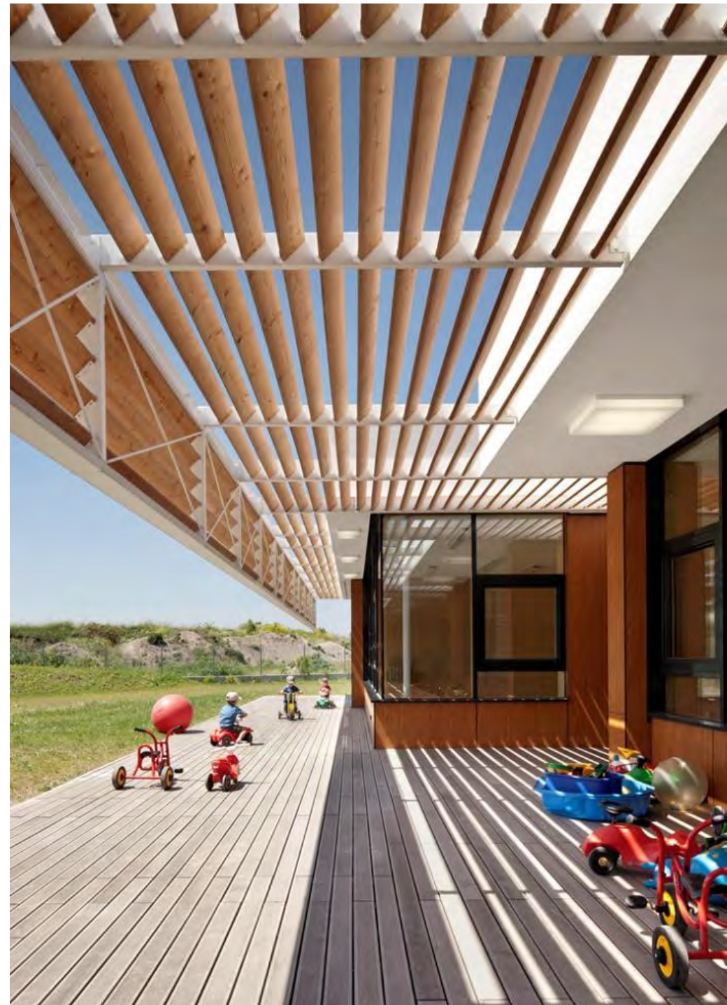
Brise-soleil en bois protégeant la façade et les fenêtres ( https://archzine.fr/ )
