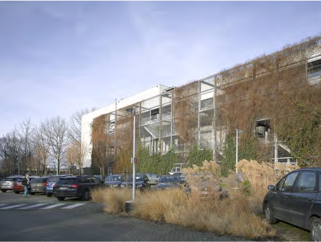
Façade avec paroi végétale sur un support séparé du mur (façade verte apposée ou séparée), Bâtiment exemplaire Caméléon © Yvan Glavie
