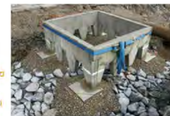
Positionnement, sur la première couche de grosses pierres compactées, du cadre en béton supportant la grille de pied d'arbre et protégeant la motte des fondations du revêtement de surface.
