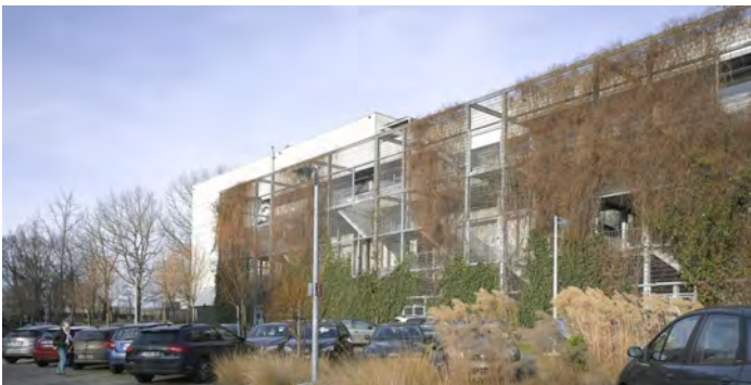
Façade végétalisée sur une structure indépendante de la façade © Yvan Glavie
