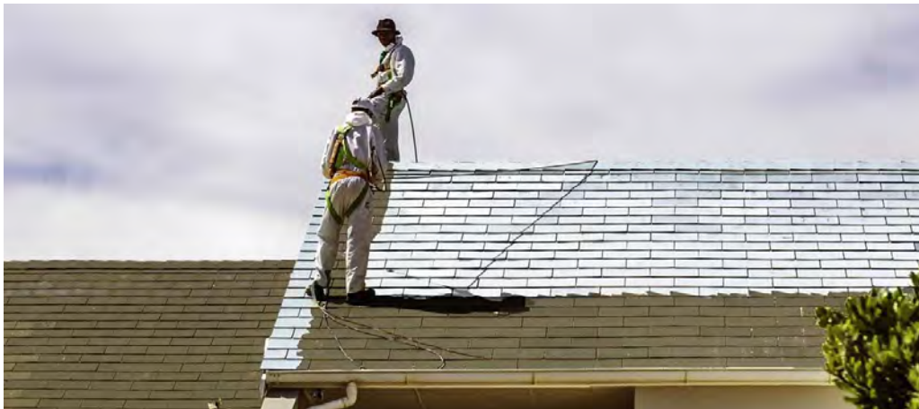
Toiture repeinte en blanc © Lakeview_Images - getty images
