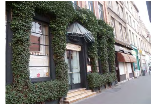
Façade végétalisée de lierre ; ombrage efficace du mur au niveau du rez-de-chaussée, qui ne s'échauffera pas. ( www.biodiversite-positive.fr , Guide BBP)
