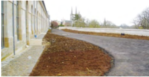
Voie d'accès pompier pas dalles alvéolées remplies de gazon (Plantes et Cité)
