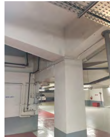
Renforts de la dalle dans le parking sous les fosses de plantation à Beaugrenelle (Paris 15 e ) © APC ( www.adaptaville.fr )
