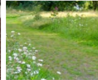
Grave compactée végétalisée © CAUE de Paris
