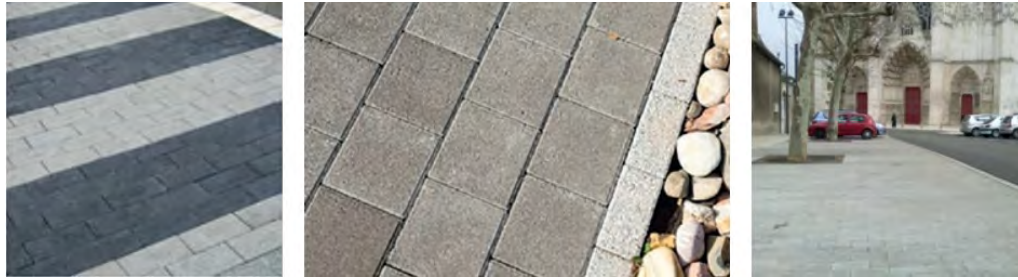
Pavés poreux (CIM Béton)
