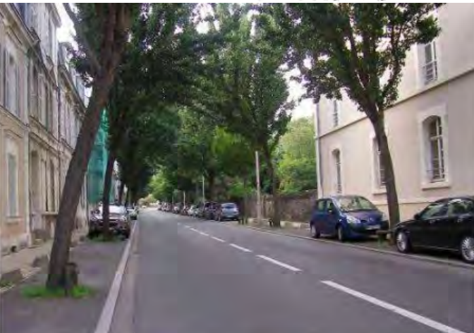
A l'âge adulte, ces arbres ont atteint une dimension incompatible avec la volumétrie de la rue, l'arbre cherchant à esquisser les façades pour trouver davantage de lumière (poiriers d'alignement, rue Rabelais à Angers, Gouédard 2014).
