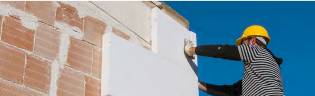
Isolation extérieure de façade ( https://energieplus-lesite.be/ )
