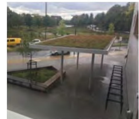
Auvent végétalisé, école A la Croisée des Chemins, Bruxelles © Ville de Paris
