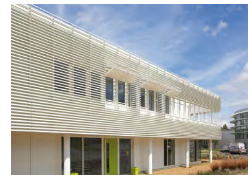
Protections solaires en lamelles horizontales (www.renson.eu)
