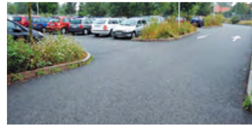
Enrobé poreux sur structure réservoir (© Lille Métropole)
