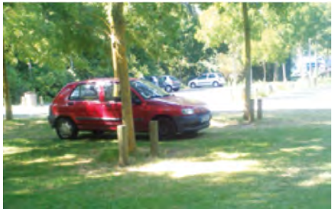
Mélange terre-pierre pour zone de stationnement (© P&C - Andréa Loreau, Plantes et Cité)
