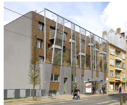
Protection solaires de la façade par une façade verte avec paroi végétale séparée. A gauche : Ch de Neestalle, Forest (Source : Yvan Glavie). A droite : Bât Alpine Finanz, Suisse (source : Jakob).
