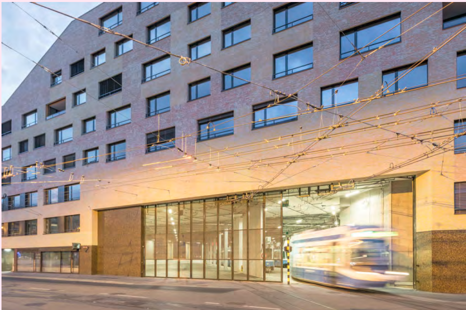
In het coöperatieve woonproject Kalkbreite wordt de plint ingezet voor tramdepot en commerciële activiteiten.
